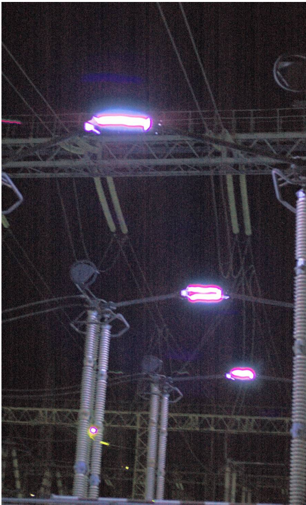
Рисунок 3.12 - Коммутация разъединителем 500 кВ И ВЧ-помехи в кабелях вторичных цепей
