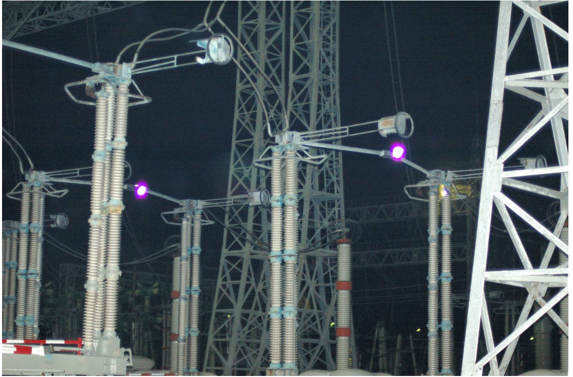
Рисунок 3.10 – Коммутация разъединителя 500 кВ
